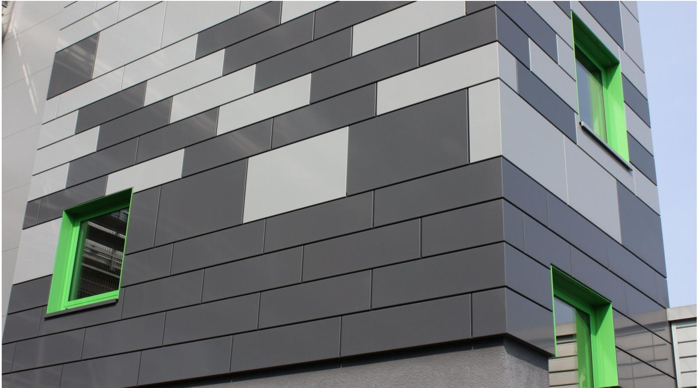
Systemfassade nach Maß: VHF – Fassade aus waagerechter Aluminiumpaneele mit individuellen Abmessungen, pulverbeschichtet nach RAL – Farbkarte oder in verschiedenen Eloxalfarbtönen sowie aus Edelstahl oder Messing
