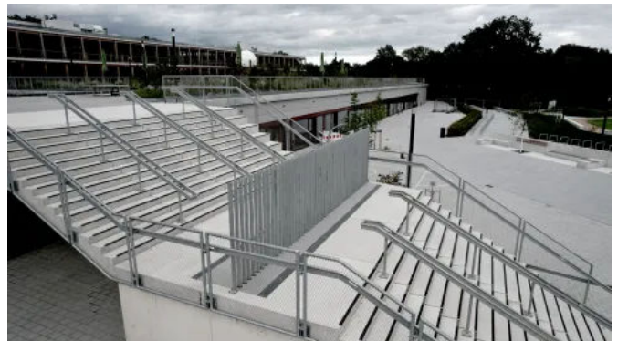
Gymnasium Langenhagen | Treppenanlage mit komplett versenkbaren Pfosten
