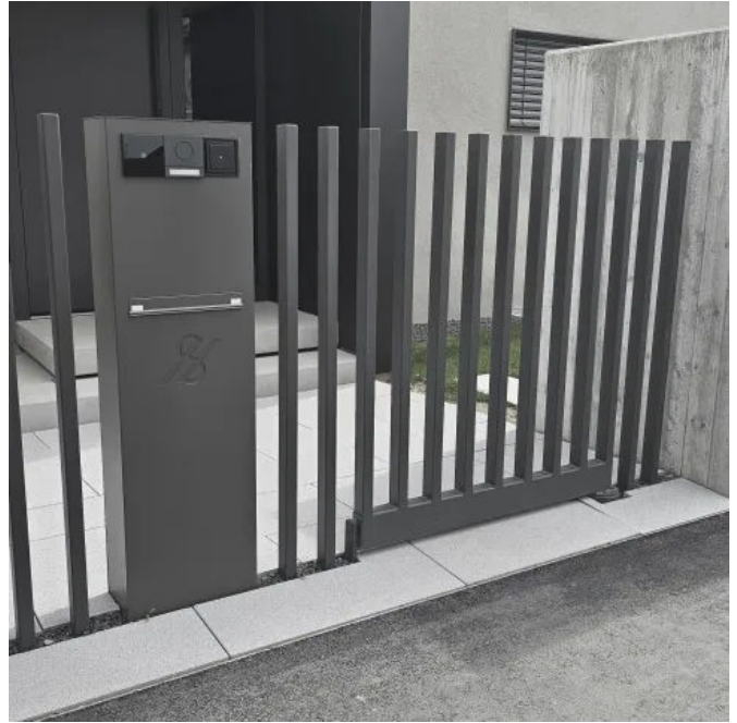
Eingangstor mit Briefkasten- und Klingelanlage
