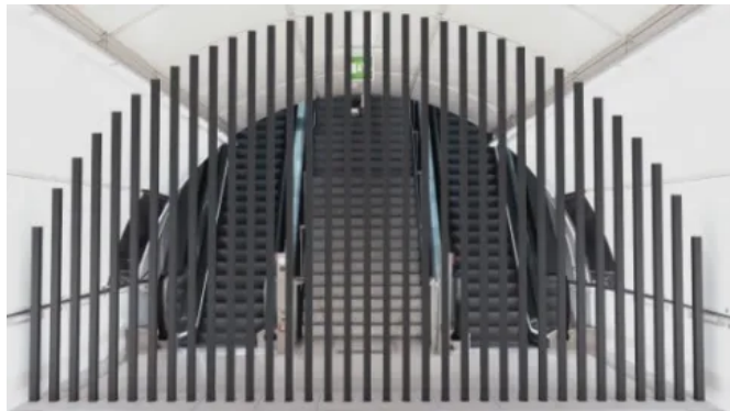
U-Bahn-Station | temporäre Abspernung an die Dachform angepasst
