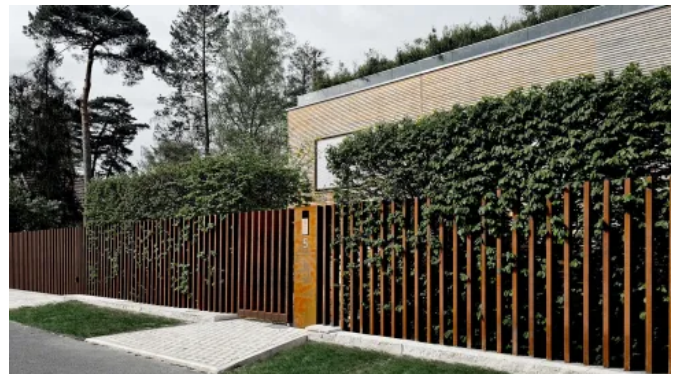
Private Zaun- und Toranlage | mit feststehenden Zaunpfosten und versenkbaren Torpfosten in Cortenstahl
