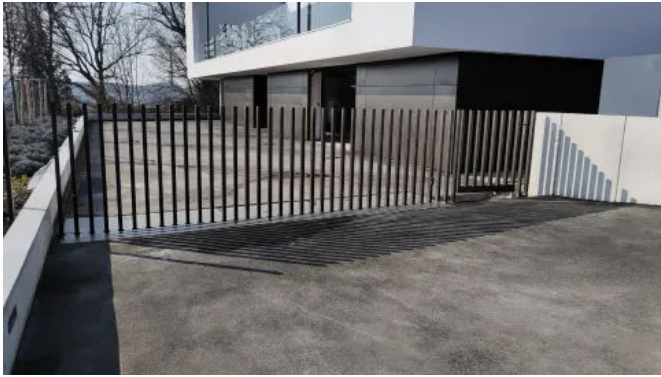
Private Toranlage mit Eingangstor
