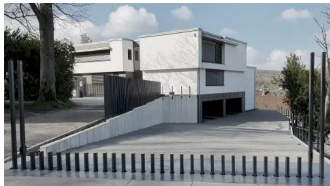
Private Zaun- und Toranlage mit versenkbaren Torpfosten bei abschüssigem Gelände.
