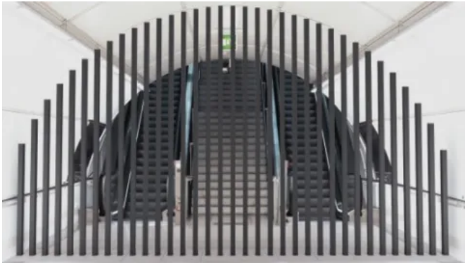
U-Bahn-Station | temporäre Abspernung an die Dachform angepasst
