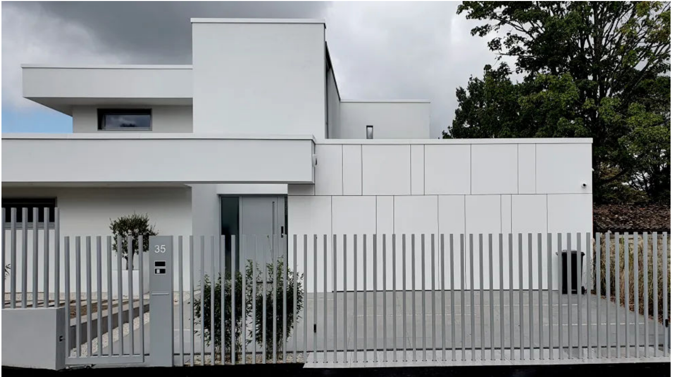
Private Zaunanlage in Bitburg mit feststehenden und versenkbaren Pfosten, schwenkbarem Gartentor sowie Briefkasten- und Klingelanlage
