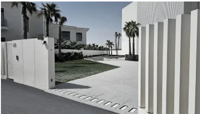
Eingefahrene Pfosten mit großem Querschnitt bei einer privaten Zaunanlage in Dubai
