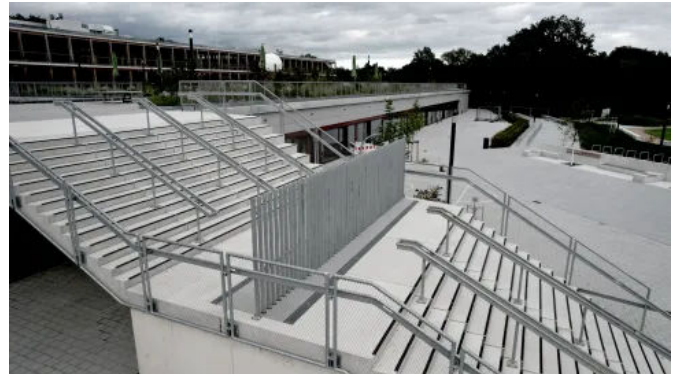
Gymnasium Langenhagen | Treppenanlage mit komplett versenkbaren Pfosten
