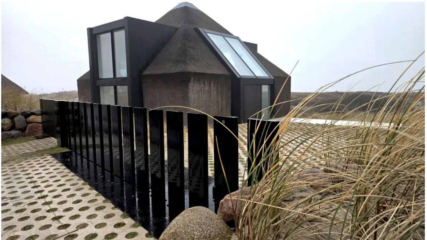
Private Toranlage auf Sylt mit versenkbaren Paneelen
