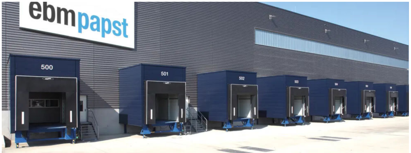
Versandzentrum ebmpapst Muldingen GmbH & Co. KG
