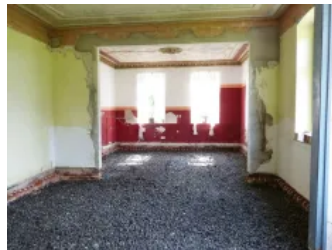
Anwendungsbild Beispiel Fußbodensanierung mit Estrich, Schritt 2
