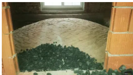
Anwendungsbeispiel Sanierung Gewölbedämmung
