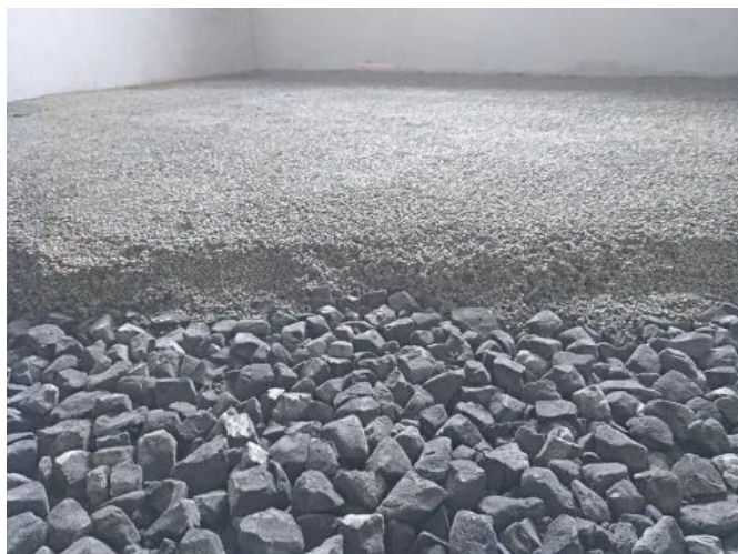
Anwendungsbild Beispiel Fußbodensanierung, Blähglas zementgebunden
