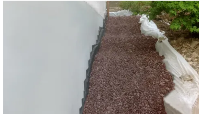
Anwendungsbeispiel Sanierung Vertikale Mauer- und Drainageschüttung
