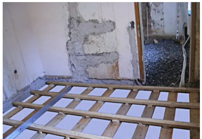
Anwendungsbeispiel Fußbodensanierung ohne Estrich
