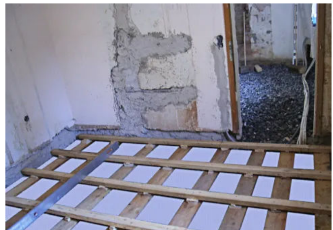
Anwendungsbeispiel Fußbodensanierung ohne Estrich
