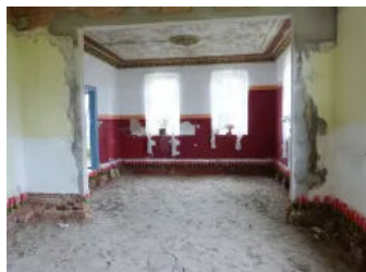
Anwendungsbild Beispiel Fußbodensanierung mit Estrich, Schritt 1
