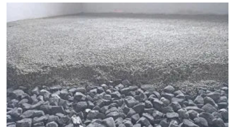
Anwendungsbeispiel Sanierung Gewölbedämmung
