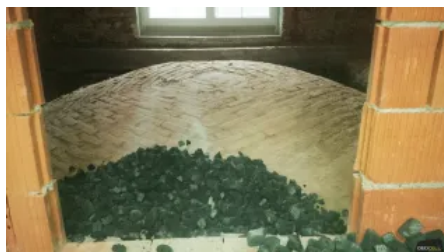
Anwendungsbeispiel Sanierung Gewölbedämmung
