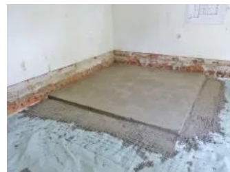
Anwendungsbild Beispiel Fußbodensanierung mit Estrich, Schritt 4
