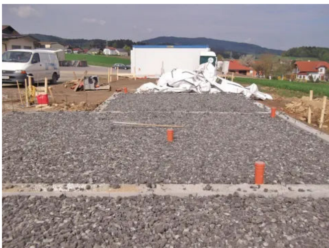
Anwendungsbildung Bodenaufbau mit Streifenfundament
