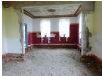
Anwendungsbild Beispiel Fußbodensanierung mit Estrich, Schritt 1
