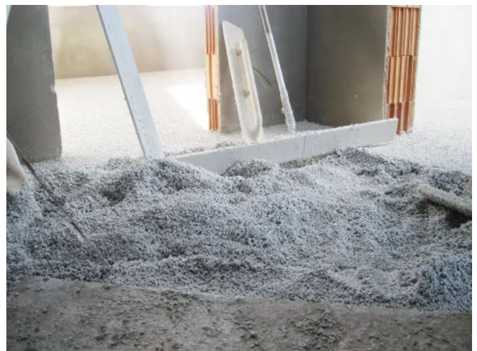
Anwendungsbild Beispiel Fußbodensanierung, Blähglas mineralisch gebunden
