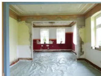
Anwendungsbild Beispiel Fußbodensanierung mit Estrich, Schritt 3
