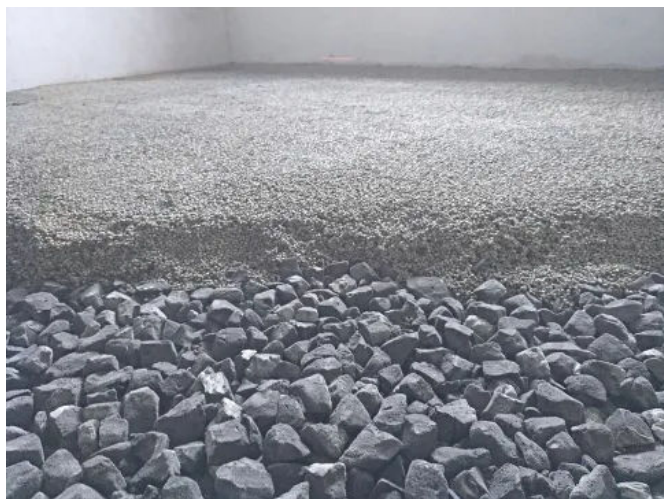
Anwendungsbild Beispiel Fußbodensanierung, Blähglas zementgebunden
