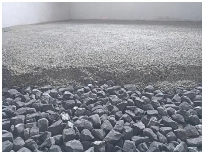
Anwendungsbild Beispiel Fußbodensanierung, Blähglas zementgebunden
