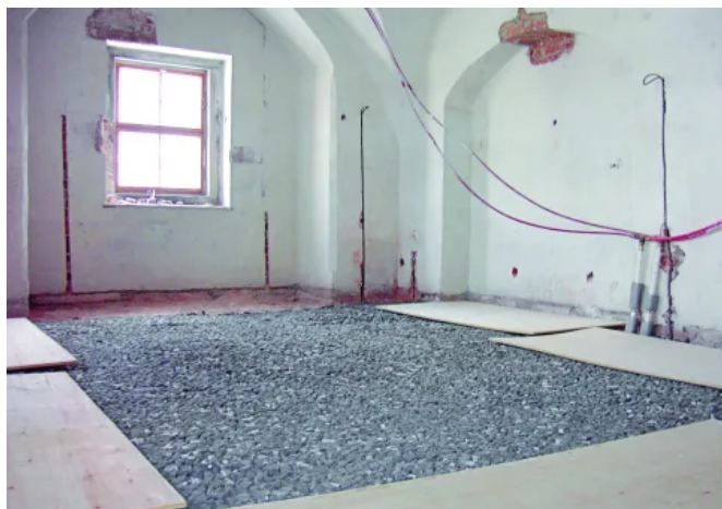
Anwendungsbeispiel Fußbodensanierung ohne Estrich
