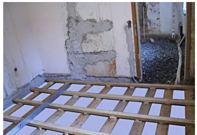
Anwendungsbeispiel Fußbodensanierung ohne Estrich
