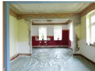
Anwendungsbild Beispiel Fußbodensanierung mit Estrich, Schritt 3
