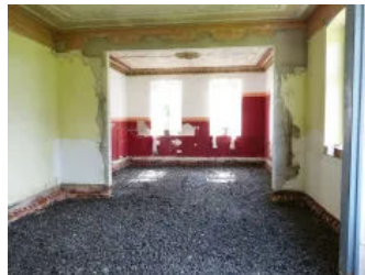
Anwendungsbild Beispiel Fußbodensanierung mit Estrich, Schritt 2
