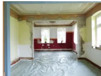
Anwendungsbild Beispiel Fußbodensanierung mit Estrich, Schritt 3
