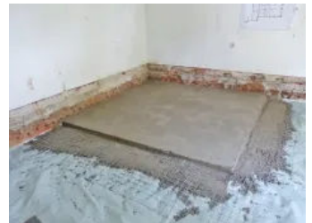
Anwendungsbild Beispiel Fußbodensanierung mit Estrich, Schritt 4
