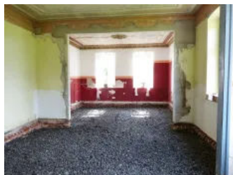
Anwendungsbild Beispiel Fußbodensanierung mit Estrich, Schritt 2
