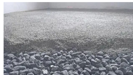
Anwendungsbeispiel Sanierung Gewölbedämmung
