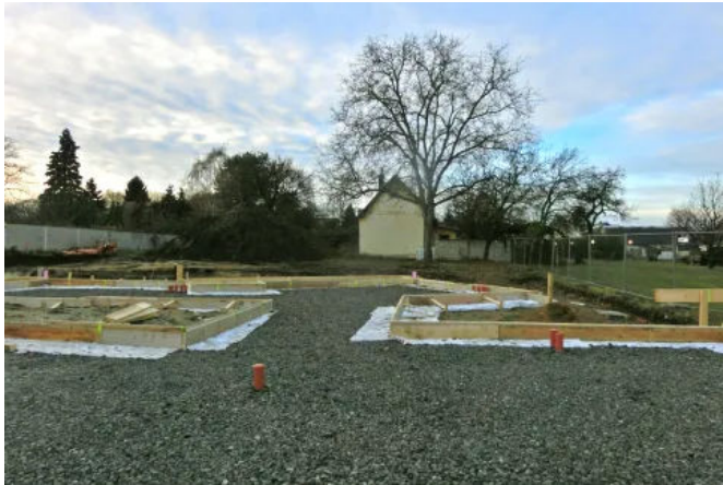
Anwendungsbildung Bodenaufbau ohne Streifenfundament
