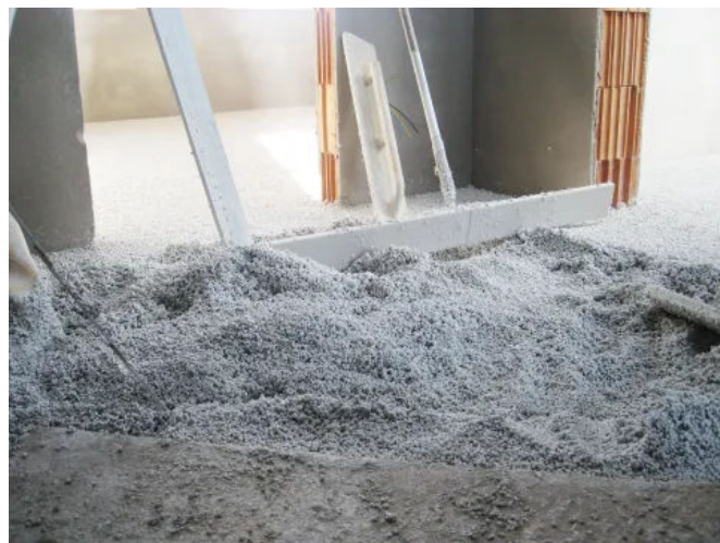
Anwendungsbild Beispiel Fußbodensanierung, Blähglas mineralisch gebunden
