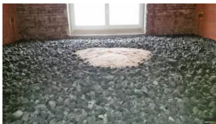
Anwendungsbeispiel Sanierung Gewölbedämmung
