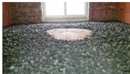
Anwendungsbeispiel Sanierung Gewölbedämmung
