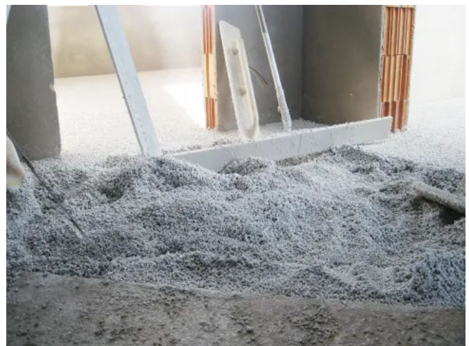
Anwendungsbild Beispiel Fußbodensanierung, Blähglas mineralisch gebunden
