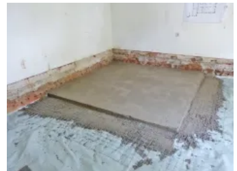
Anwendungsbild Beispiel Fußbodensanierung mit Estrich, Schritt 4
