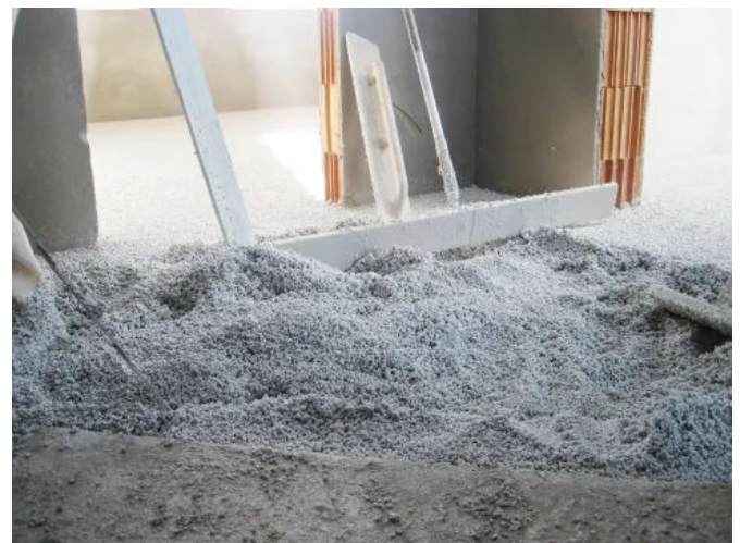
Anwendungsbild Beispiel Fußbodensanierung, Blähglas mineralisch gebunden
