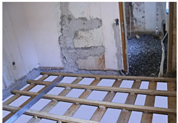
Anwendungsbeispiel Fußbodensanierung ohne Estrich
