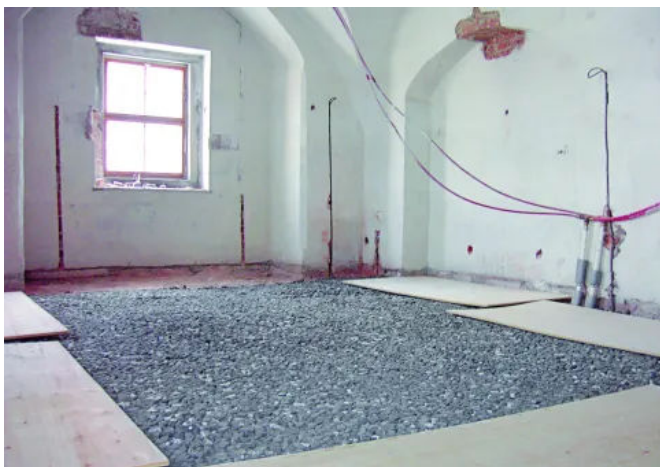
Anwendungsbeispiel Fußbodensanierung ohne Estrich
