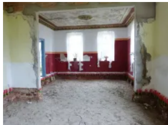
Anwendungsbild Beispiel Fußbodensanierung mit Estrich, Schritt 1
