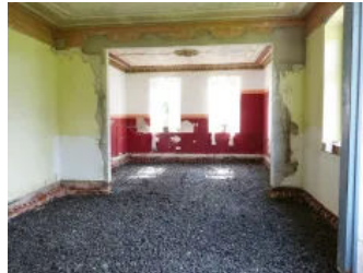
Anwendungsbild Beispiel Fußbodensanierung mit Estrich, Schritt 2
