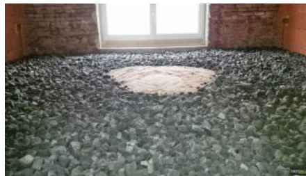
Anwendungsbeispiel Sanierung Gewölbedämmung
