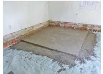
Anwendungsbild Beispiel Fußbodensanierung mit Estrich, Schritt 4
