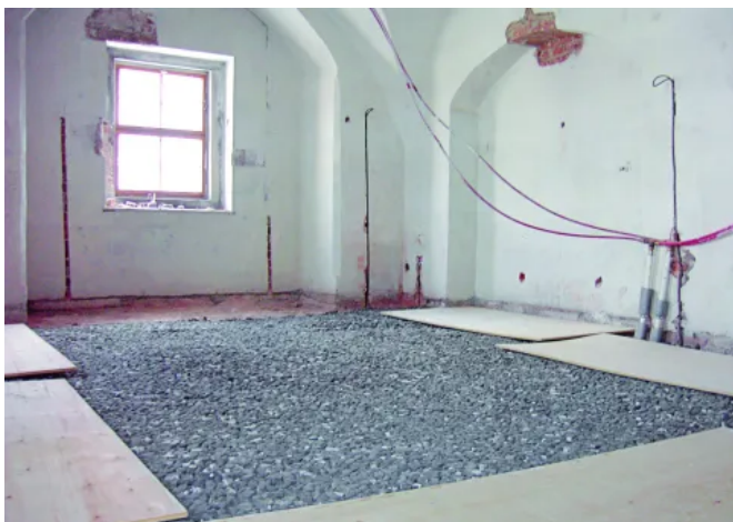
Anwendungsbeispiel Fußbodensanierung ohne Estrich
