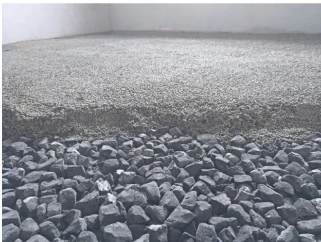
Anwendungsbild Beispiel Fußbodensanierung, Blähglas zementgebunden
