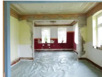
Anwendungsbild Beispiel Fußbodensanierung mit Estrich, Schritt 3
