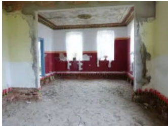
Anwendungsbild Beispiel Fußbodensanierung mit Estrich, Schritt 1
