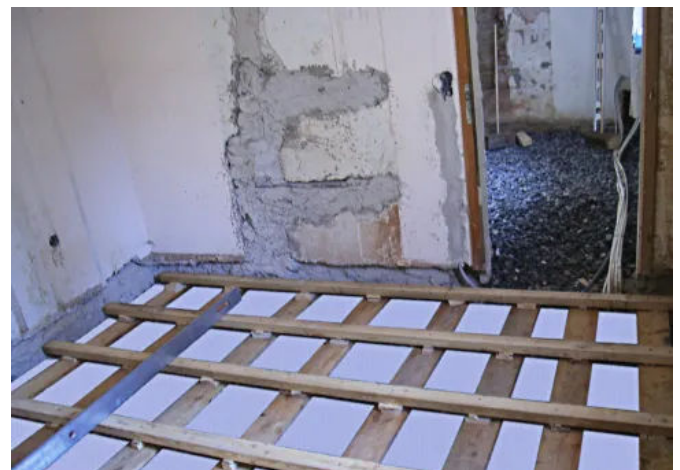
Anwendungsbeispiel Fußbodensanierung ohne Estrich
