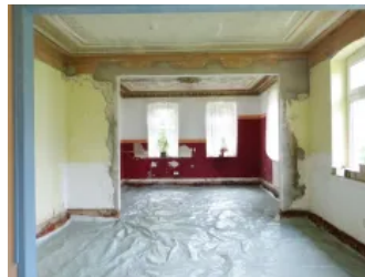
Anwendungsbild Beispiel Fußbodensanierung mit Estrich, Schritt 3
