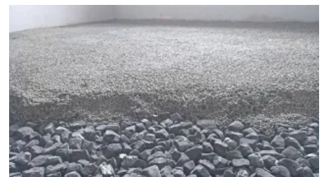
Anwendungsbeispiel Sanierung Gewölbedämmung
