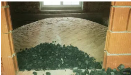
Anwendungsbeispiel Sanierung Gewölbedämmung
