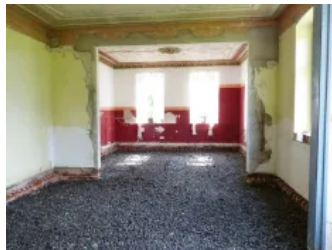
Anwendungsbild Beispiel Fußbodensanierung mit Estrich, Schritt 2
