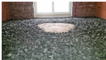
Anwendungsbeispiel Sanierung Gewölbedämmung
