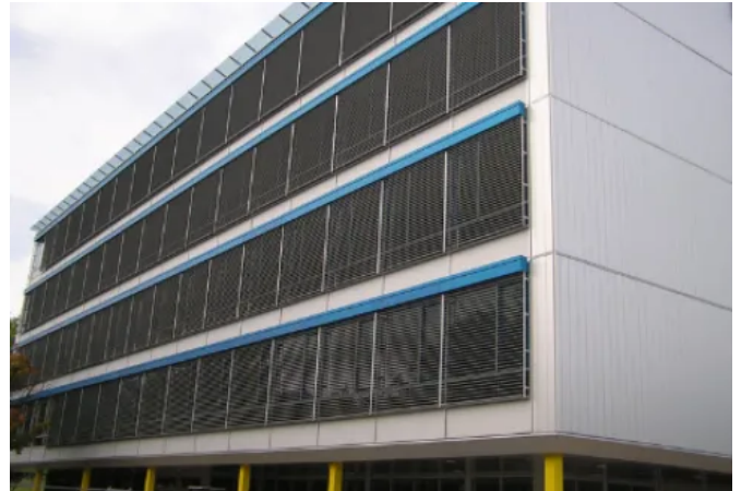
Schule Roche Nyon
