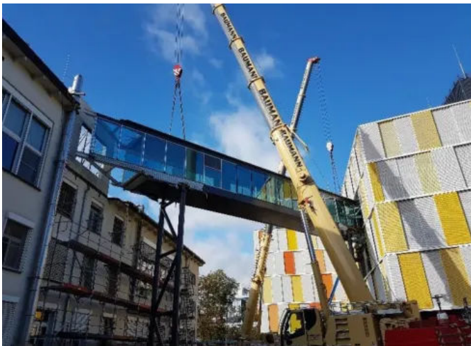
Verbindungsbrücke, ELKI Uni-Klinikum, Bonn
