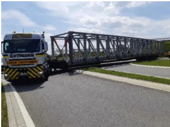
Brücke, Bahnhof Merklingen
