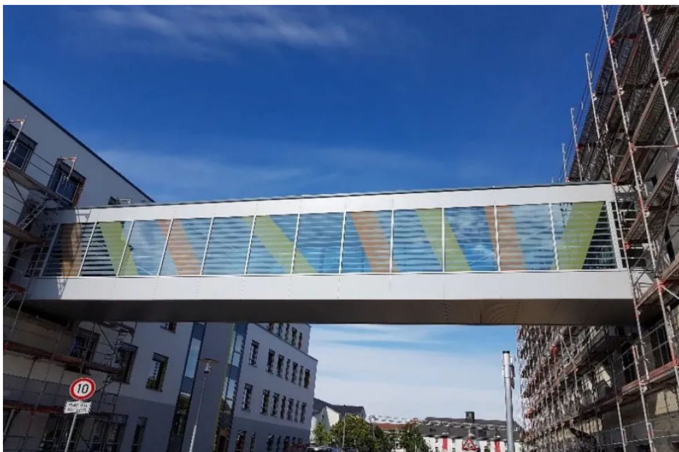
Brücke, VITOS Verbindungsbrücke KJP, Hanau
