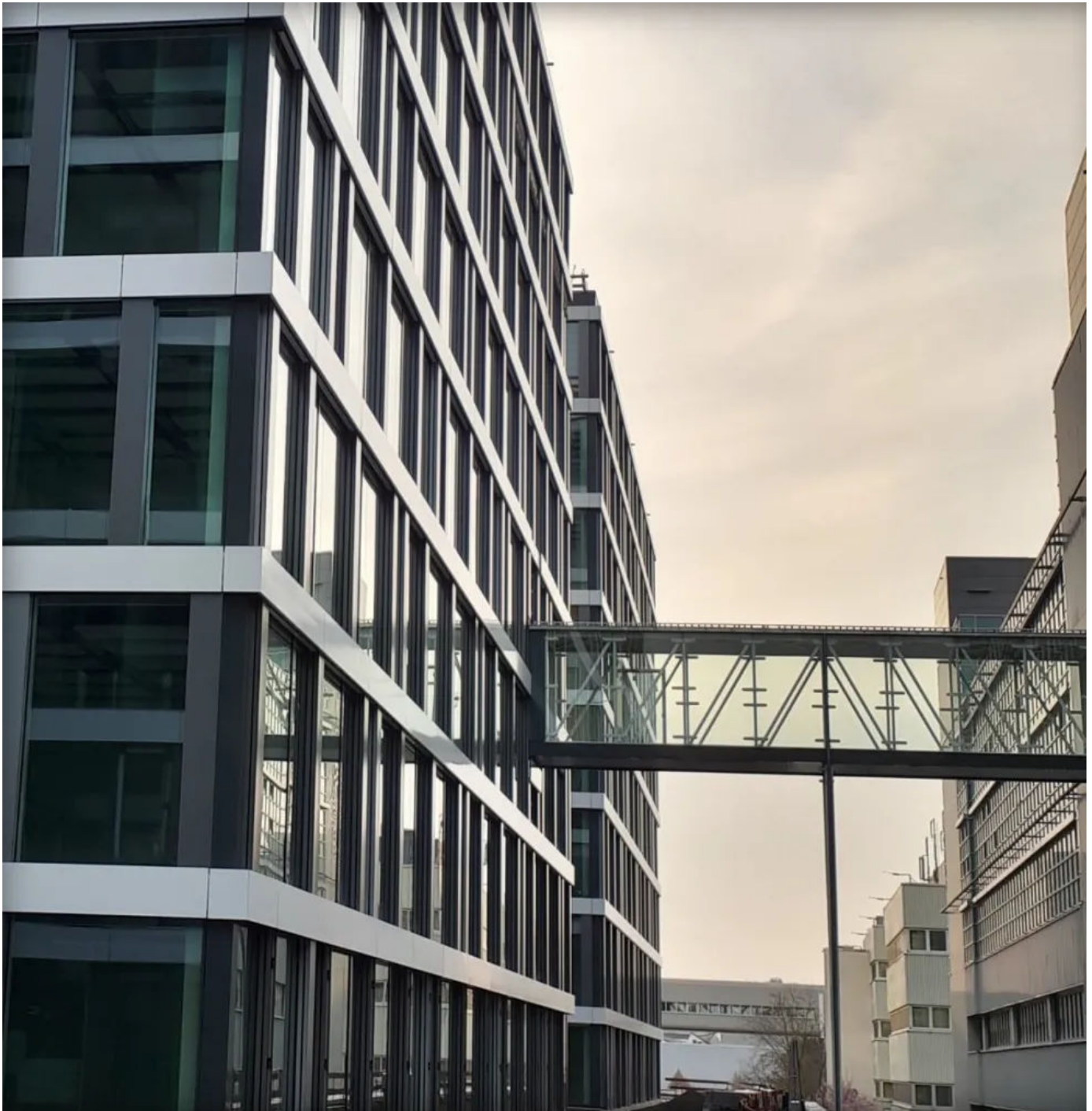
Verbindungsbrücke DAIMLER, Sindelfingen
