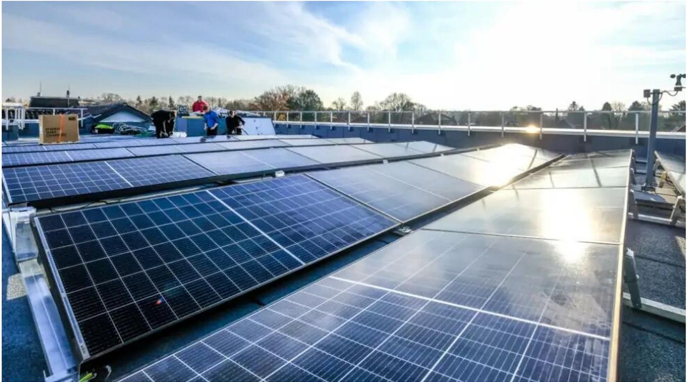
Das aerodynamische Solarsystem PV easywave ist geeignet für eine maximale Dachneigung von 5°. Die Modulneigung beträgt 11°. Die Module werden ohne Bohren auf einem Schienensystem montiert.
