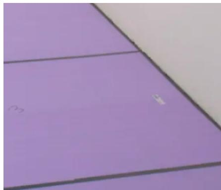
Das Element QASA-D-VT-I-B-2 XPS-5 ist als Bodeninnendämmung in Räumen über unbeheizten Kellern, ungedämmten Fundamentplatten oder auf Bodenkonstruktionen unbeheizter Dachböden einzusetzen.
