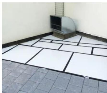
Das VIP-Bauteil QASA-D-VT-A-DA-GFK/GGR ist für geringe Aufbauhöhen als Außenflächendämmung an Balkonen, Terrassen- und Flachdächer geeignet.
