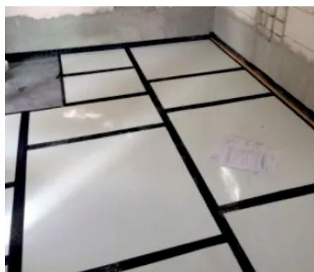
Das VIP-Element QASA-D-VT-I-Trittschall ist für geringe Bodenaufbaustärken mit Trittschallanforderungen im Innenbereich geeignet. QASA-D-VT-I-Trittschall ist eine Kombination aus Wärmedämmung und Trittschallminderung.
