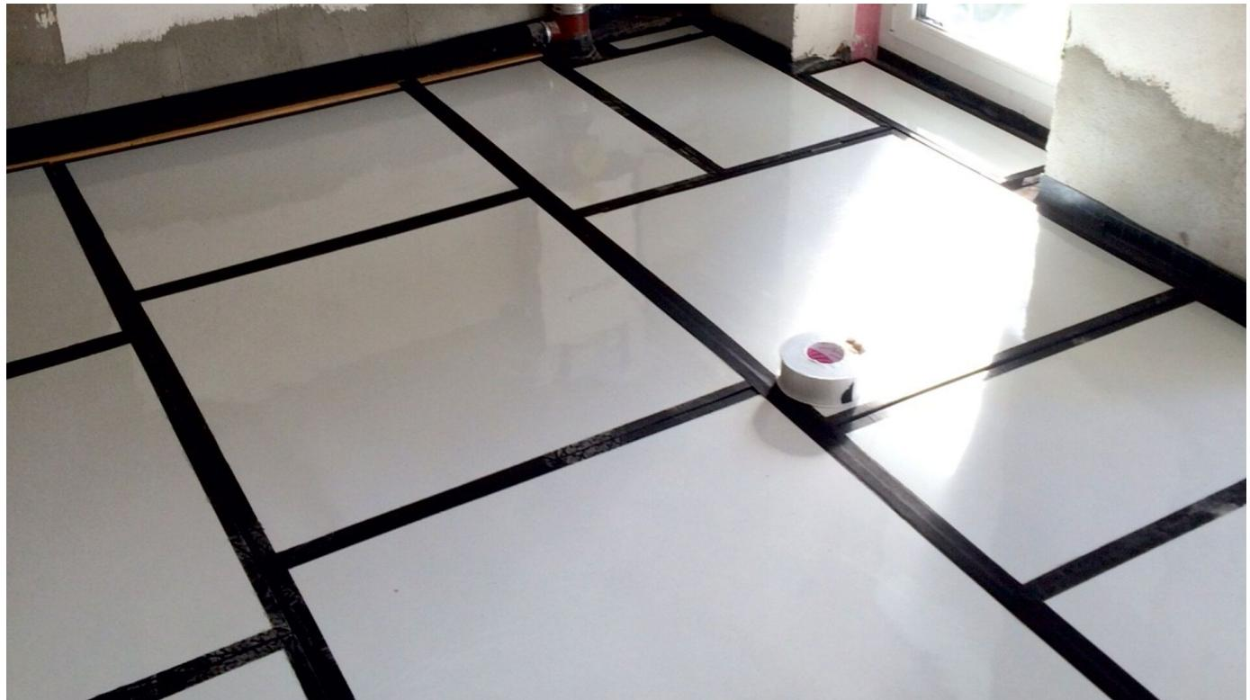
Vakuumisolationspaneele für Anwendungsbereiche mit geringen Aufbauhöhen im Innenbereich
