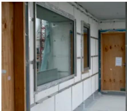
Die Befestigung der Fassadenkonstruktion erfolgt durch punktförmige Stabanker, diese durchdringen die Elemente in den Paneel-Stoßfugen. Möglich sind hochwärmédämmende Systemaufbauten mit ca. 100 mm. Die seitlichen Anschlüsse an die begrenzenden Bauteile werden mit einem systemkonformen Dämmstreifen versehen.
