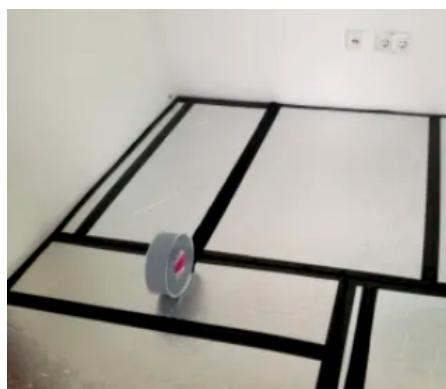
QASA-N-VT-VIP blank sind unkaschierte Vakuumdämmpaneelen ohne Schutz- bzw. Deckschichten, jedoch mit Kantenschutzband als Stoßschutz.
