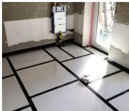
Für Räume über unbeheizten Kellern, ungedämmten Fundamentplatten oder Bodenkonstruktionen unbeheizter Dachböden ist das QASA-D-VT-I-B-GFK-XPS-5 geeignet.
