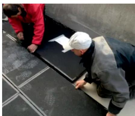
Das VIP-Element ist QASA-D-VT-A-DA-2 R-GGR für die Einsatzbereiche als Balkon-, Terrassen- und Flachdachdämmung geeignet. Durch die mit dem VIP-Paneele kraftschlüssig verbundenen Gummiplatten-Deckschichten wird eine beidseitig geschützte Oberfläche erreicht.
