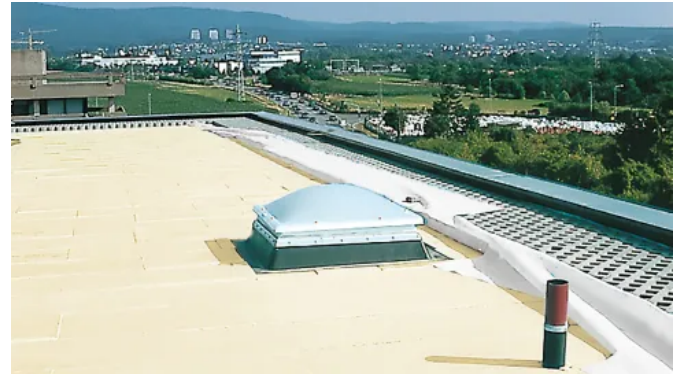
Gedämmtes Umkehrdach
