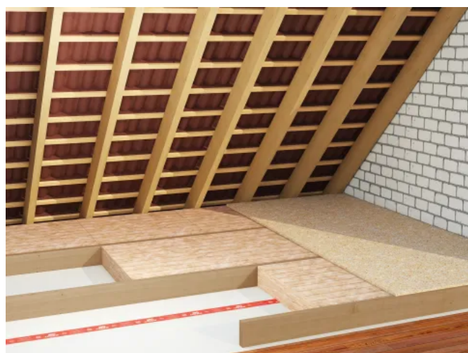
Oberste Geschossdecke mit PureOne
