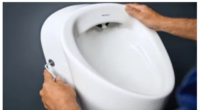
Einfache Installation eines Renova Urinals
