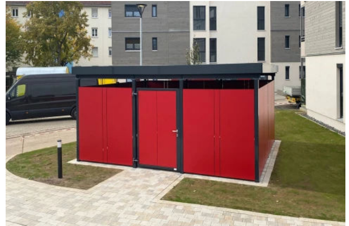
Müllhaus, Trespa rot
