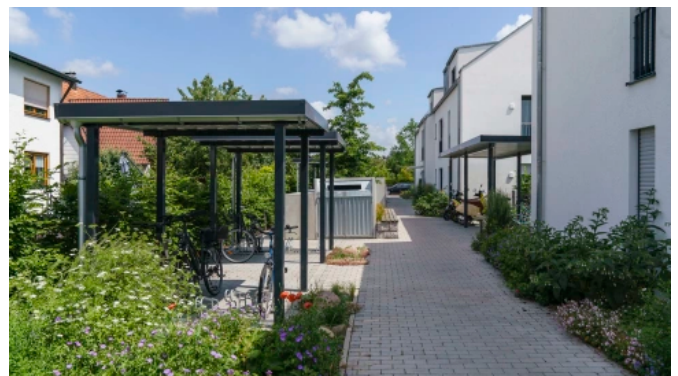
Offene Fahrradüberdachung, Trapezblechdach
