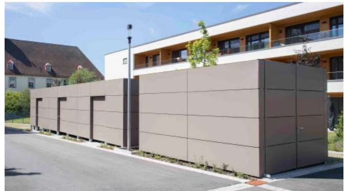
Müllhaus - Gründach light, Seitenverkleidung Trespa
