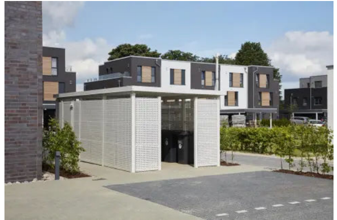
Müllhaus, Lochblech pulverbeschichtet
