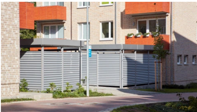
Fahrradhäuser - Trapezblechdach, Seitenverkleidung Stahlwellblech, Hängeschiebetor
