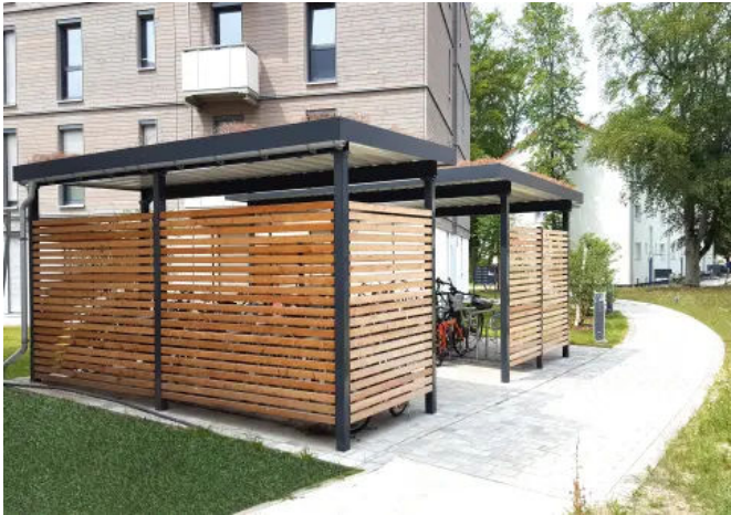
Fahrradüberdachung, Gründach light, Woodline 22 mm
