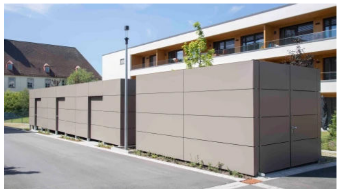
Müllhaus - Gründach light, Seitenverkleidung Trespa
