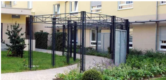
Pergola-Eingang — Tragkonstruktion Ambiente
