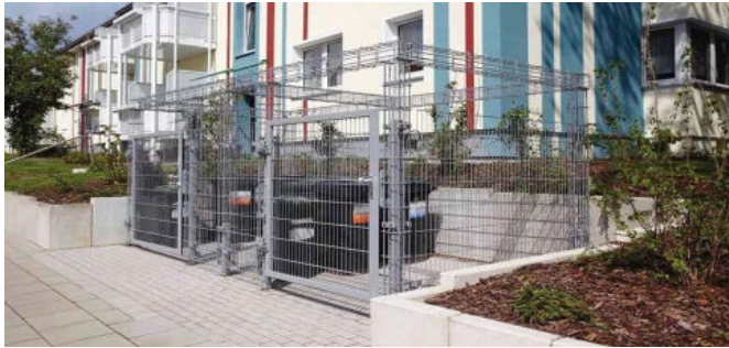
Müllplatz, Tragkonstruktion Drahtbalken mit Gittermatten
