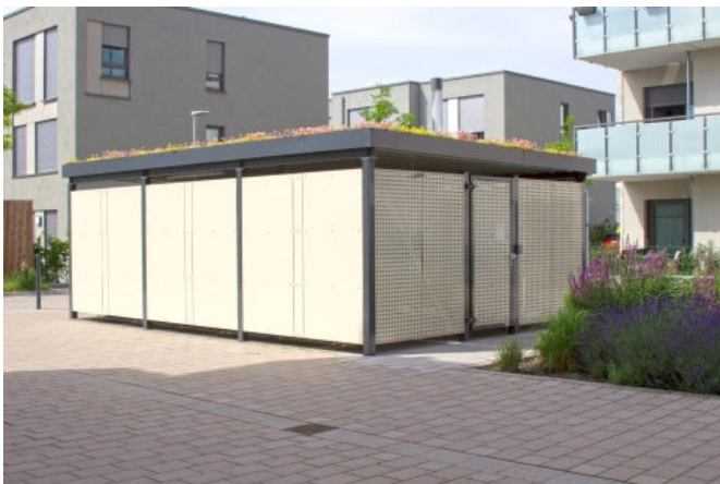
Mülleinhausung, Gründach light, Lochblech und Vollblech pulverbeschichtet
