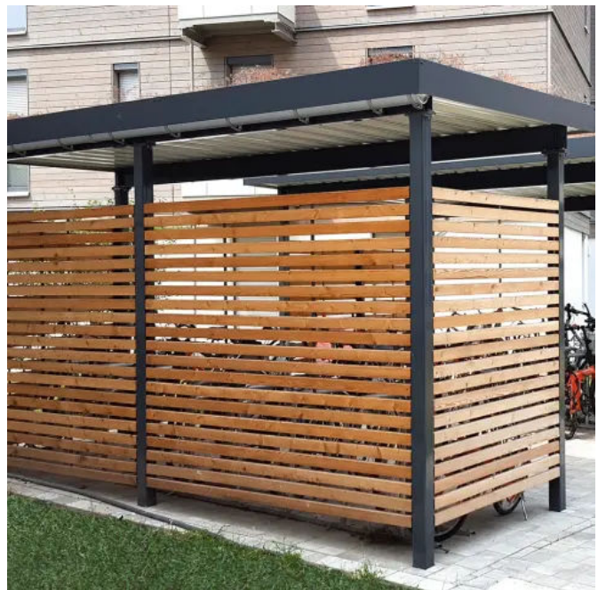
Fahrradüberdachung, Seitenverkleidung Woodline 22 mm
