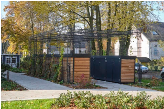
Mülltonnenboxen mit Pegelüberdachung
