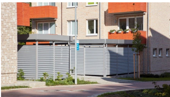
Fahrradhäuser - Trapezblechdach, Seitenverkleidung Stahlwellblech, Hängeschiebetor
