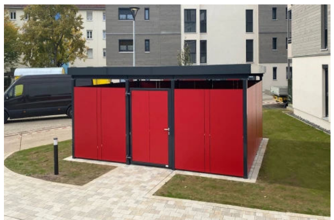
Müllhaus, Trespa rot
