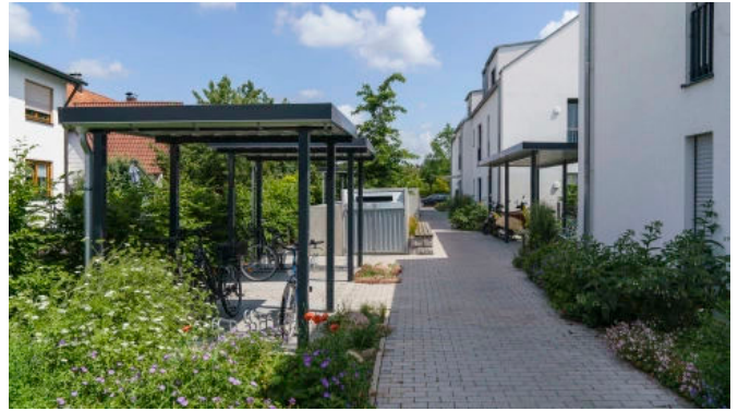
Offene Fahrradüberdachung, Trapezblechdach
