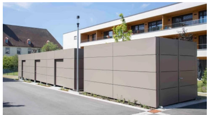
Müllhaus - Gründach light, Seitenverkleidung Trespa
