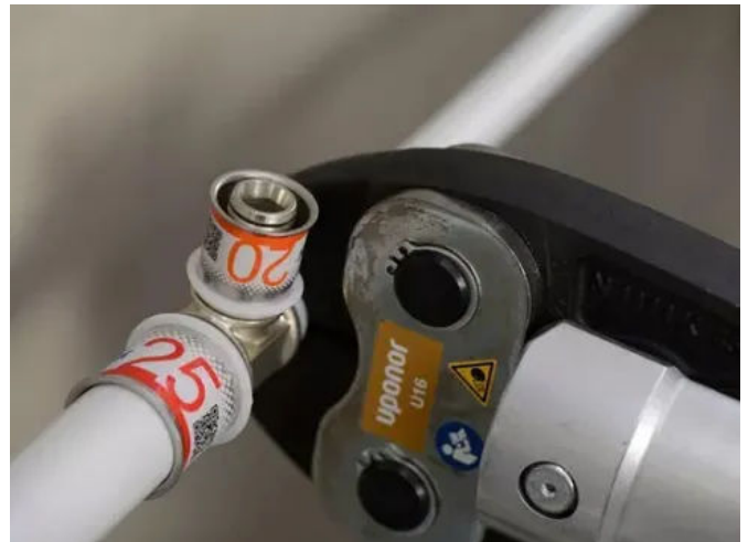
Schnell installiert in 3 Schritten: Rohr zurechtschneiden, Fitting einsetzen, Fitting pressen. Die sofortige Leckageanzeige bei unkorrekter Verpressung vermeidet Installationsschäden.
