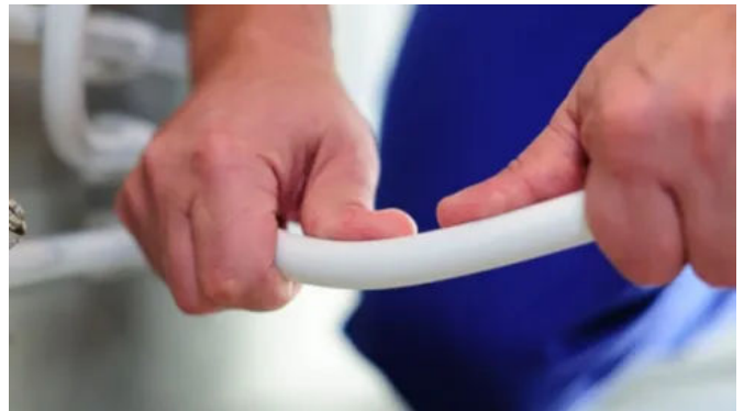
Die gute Biegebarkeit erleichtert die Installation und spart Fittings.
