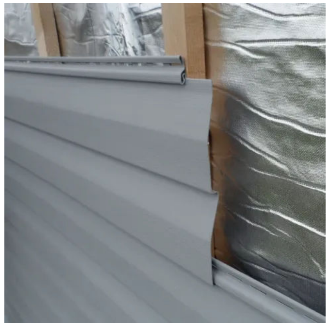
Skytech® PRO XL als Fassadenbahn, DIN EN 13859-2
