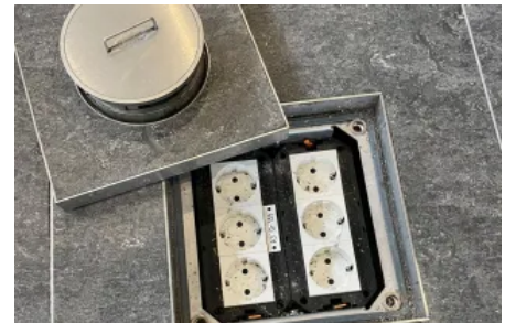
OKA-Kanäle ermöglichen den Einbau von Geräteeinsätzen für Steckdosen, Daten- und Multimediaanschlüsse (z.B. HDMI, USB).
