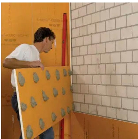
auf Rohbauwänden oder Mischuntergründen
