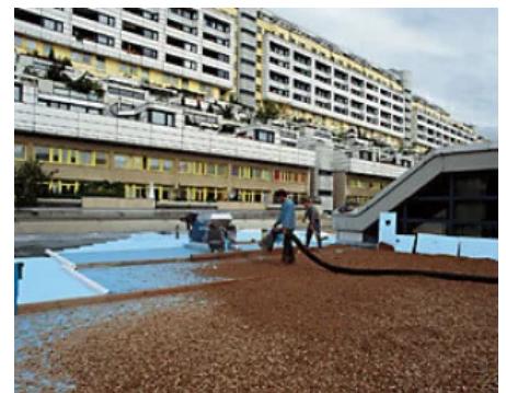
Als diffusionsoffene, wasserabweisende Trennlage folgt RAVATHERM™ XPS MK und anschließend die Kiesschicht
