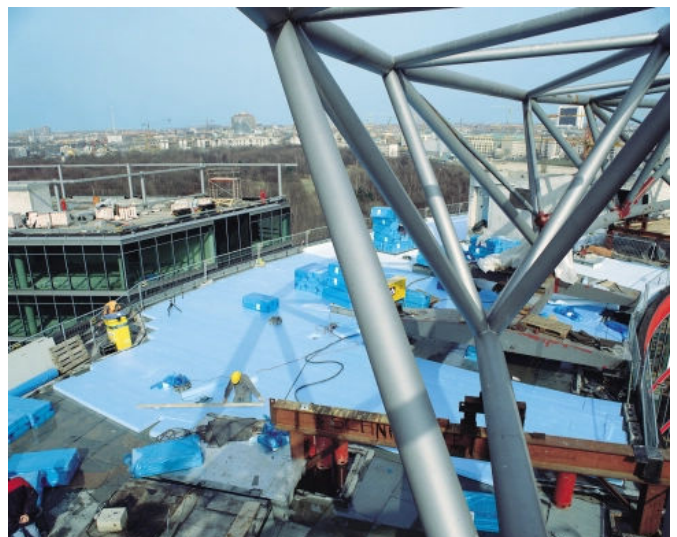
Die blauen RAVATHERM™ XPS Dämmplatten schützen die Dachabdichtung während der Bauphase (hier Sony Center, Berlin)
