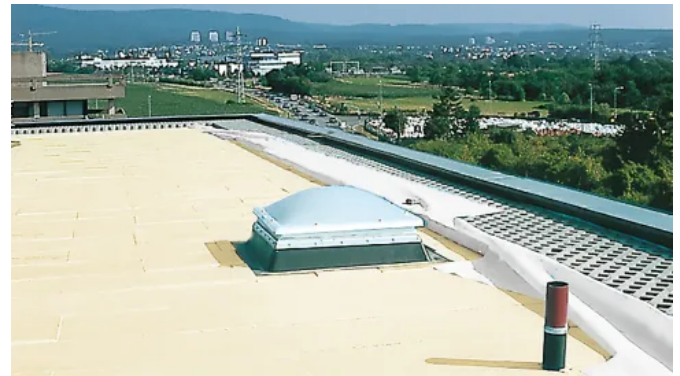
Gedämmtes Umkehrdach
