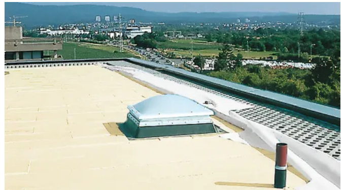
Gedämmtes Umkehrdach
