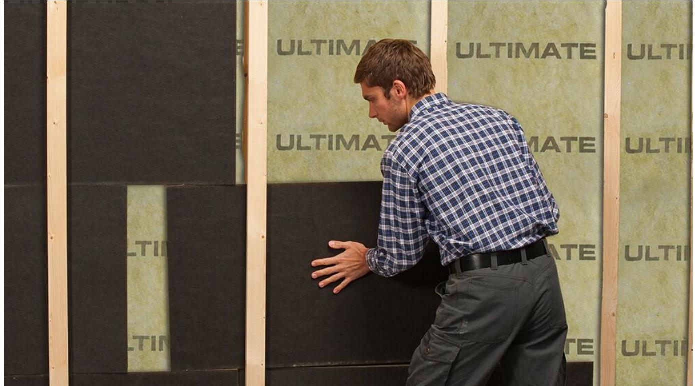
Die nichtbrennbare Hochleistungs-Mineralwolle ULTIMATE zeigt auch im Holzrahmenbau seine Stärken und schützt die Konstruktionen zuverlässig vor Feuer.
