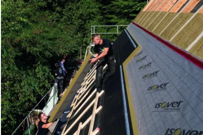
Schlanker Aufbau mit \lambda_{D31} U-Wert 0,14 mit nur 160 mm Zwischensparrendämmung und 80 mm Aufsparrendämmung
