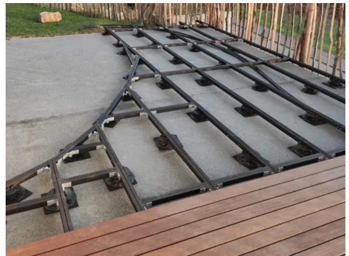
UKAL® Unterkonstruktion für abgerundete WPC-Terrasse mit Aluminiumprofilen und Stelzlager
