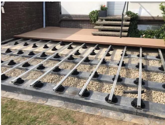
UKAL® Unterkonstruktion für WPC-Terrasse mit Aluminiumprofilen und Stelzlager
