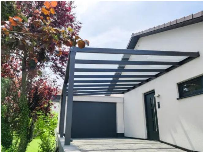
Die im Pfosten integrierte Regenrinne sorgt für eine nicht sichtbare Entwässerung der Schweng Pultdachcarports.
