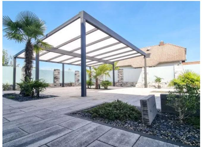
Mit der Eindeckung aus milchigem Verbundsicherheitsglas integriert sich das Pultdachcarport ästhetisch in die Umgebung.
