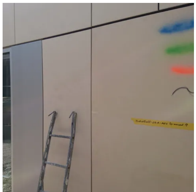
Individuell geschützter Architekturbeton, imprägniert an Testflächen mit HydroGraff® FL OS-A AGS Flüssig , Schule Berg am Leim, München
