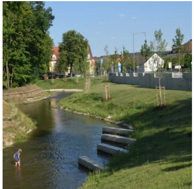
Dauerhafter Betonschutz mit HydroGraff® FL OS-A AGS Flüssig an den „Glonnterrassen“ in Allershausen
