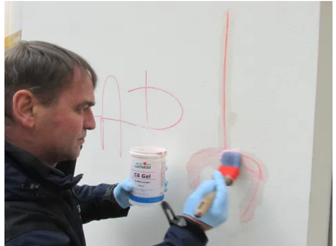
Von der mit Fluorosil® Premium geschützten Silikatfarbe kann Graffiti einfach mit Scheidel C6 Gel Graffitireiniger entfernt werden.
