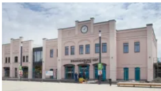
HydroPurSilan®, Bahnhof Brandenburg an der Havel
