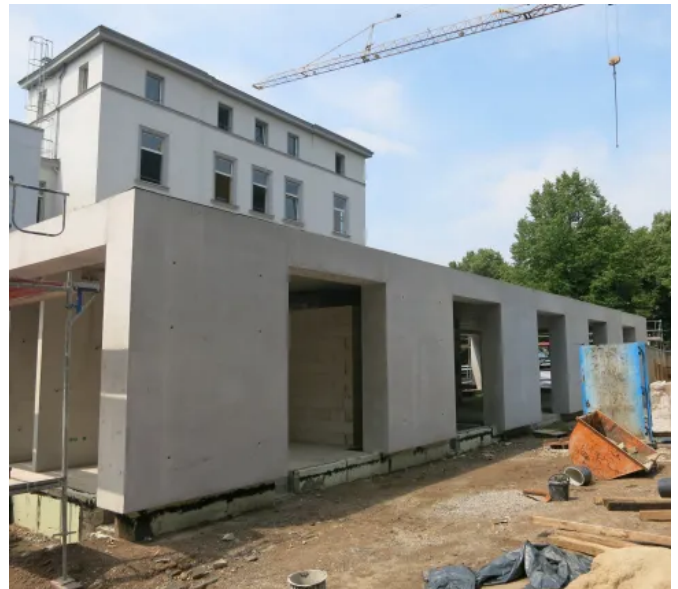
Kirchenpavillon in Bonn in der Bauphase
