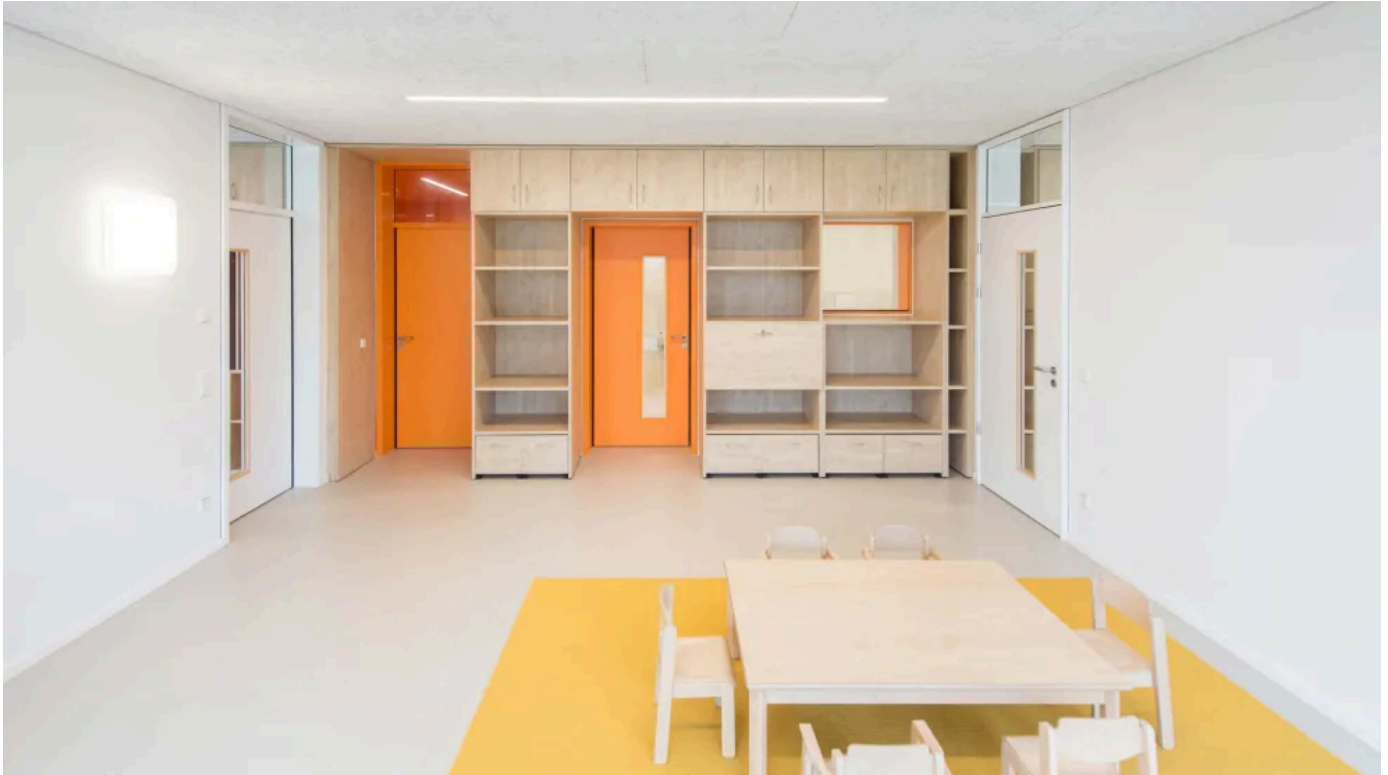
Türelemente mit Oberlicht, Lichtausschnitt und Klemmschutzlösung für Kinderfinger
