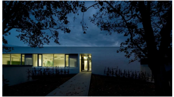
Gymnasium Leinfelden-Echterdingen | Fassadenbekleidung aus Aluminiumstrangpressprofilen in eloxierter Ausführung
