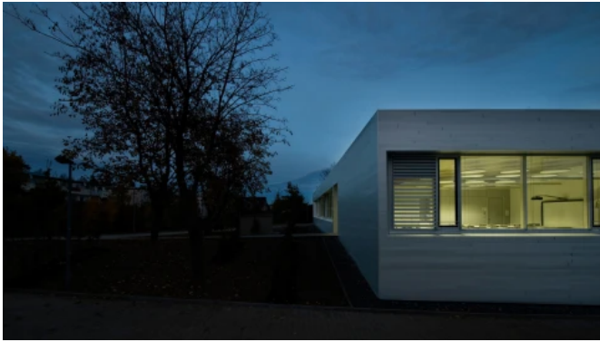
Gymnasium Leinfelden-Echterdingen | Fassadenbekleidung aus Aluminiumstrangpressprofilen in eloxierter Ausführung
