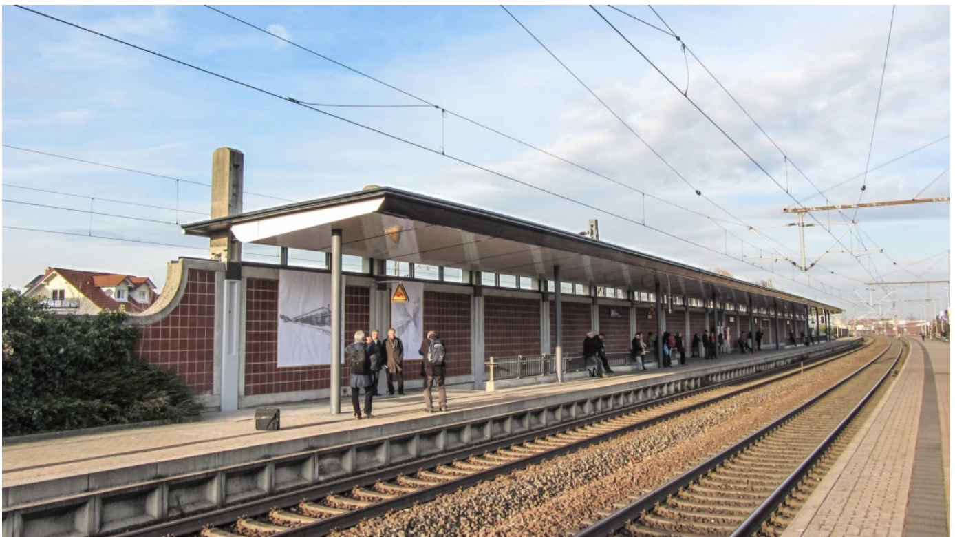
Dachunterseite mit glänzend weiß lackierten Metallpaneelen
