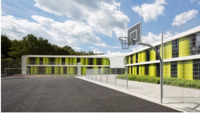
Jugendherberge Bayreuth | Aluminium-Fassade mit senkrecht angeordneten Paneelen des Y-förmigen Gebäudes
