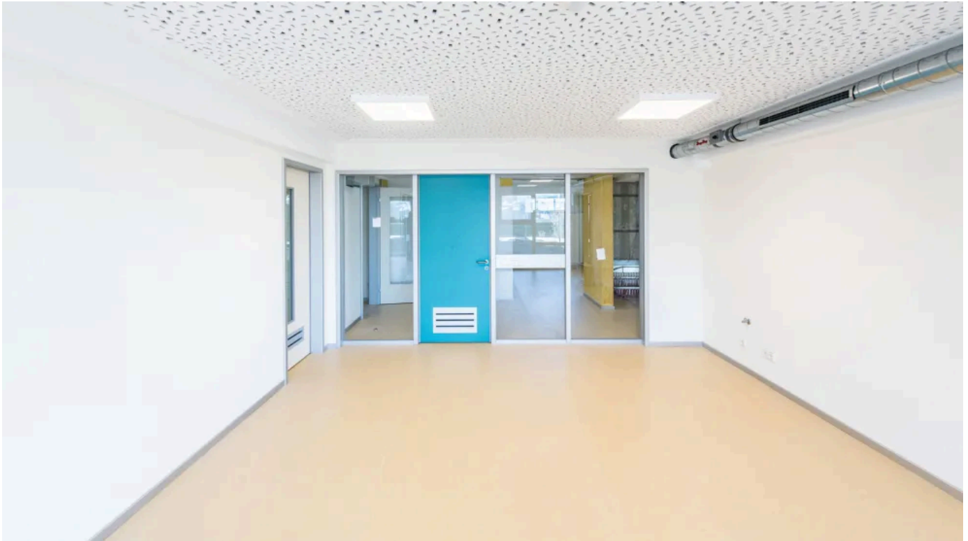
Türblatt mit Nachströmöffnung
