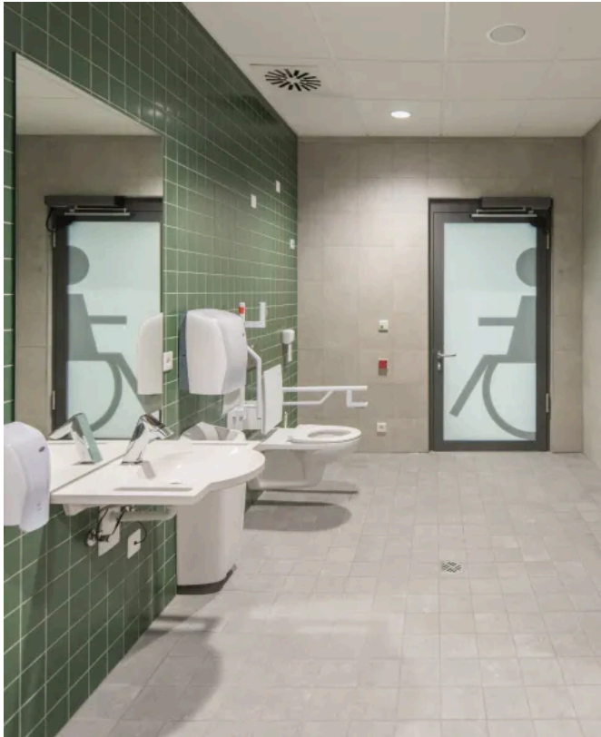
Küffner Aluminium-Rahmentür in barrierefreier WC-Anlage | Schwimmbad Georgensmünd
