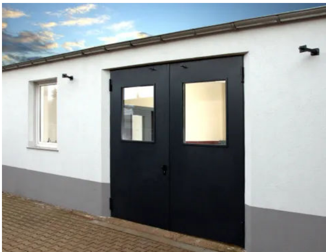
Lager- und Produktionshalle
