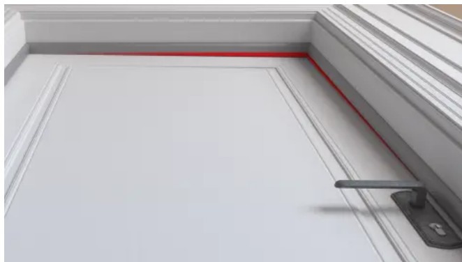
Nachträgliche Türdichtung Nadi® im Altbau.
