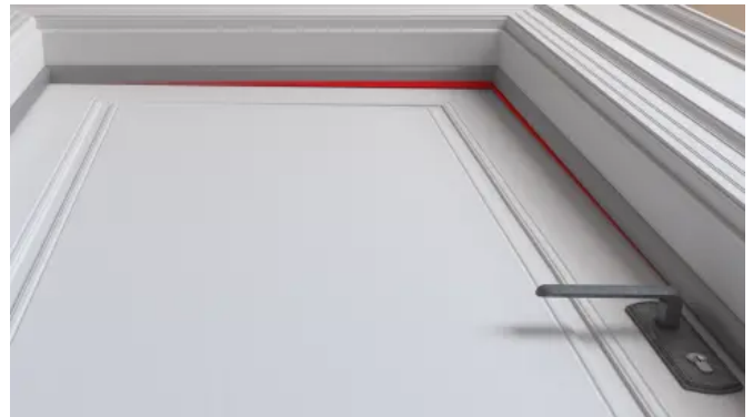
Nachträgliche Türdichtung Nadi® im Altbau.
