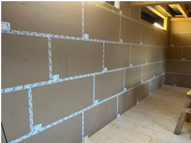
PhoneStar Platten als Schalldämmplatten an der Wand
