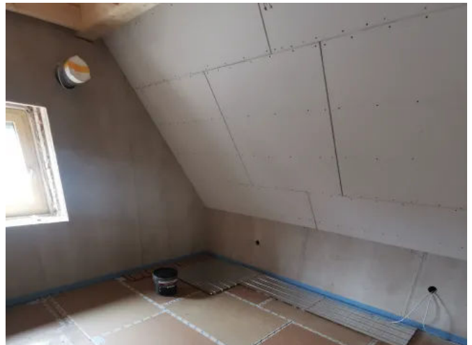
PhoneStar Platten als Schalldämmplatten an der Dachschräge
