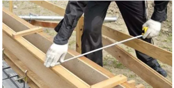
Schalungsbau mit Duripanel
