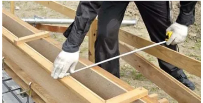
Schalungsbau mit Duripanel
