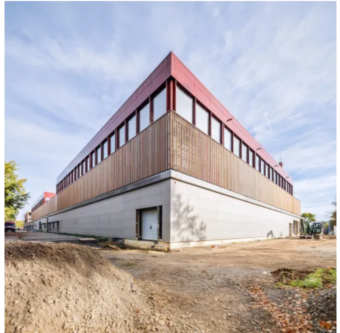
Neubau Gymnasium und Sporthalle Langenhagen mit Siniat Weather-Defence Platten
