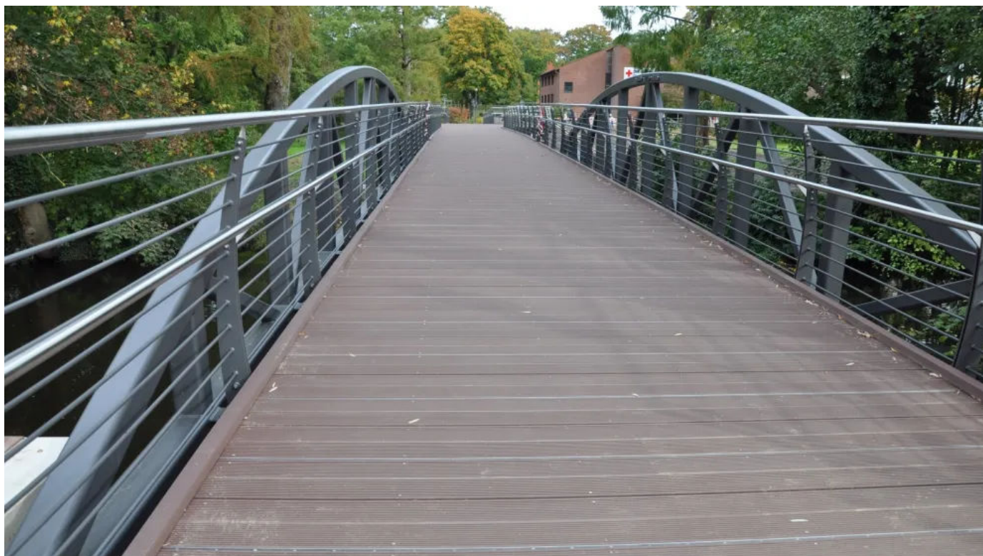
Neubau der Langen Brücke in Uelzen mit Belag aus 5 cm dicken TRIMAX® Riffelbohlen aus Kunststoff mit einer Breite von 30 cm
