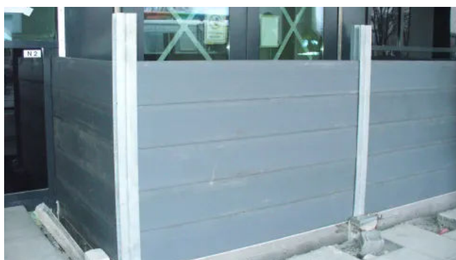
Beim Hochwasserschutz kommen regelmäßig die Nut- & Federprofile in der Dimension 5 x 25 cm zum Einsatz.
