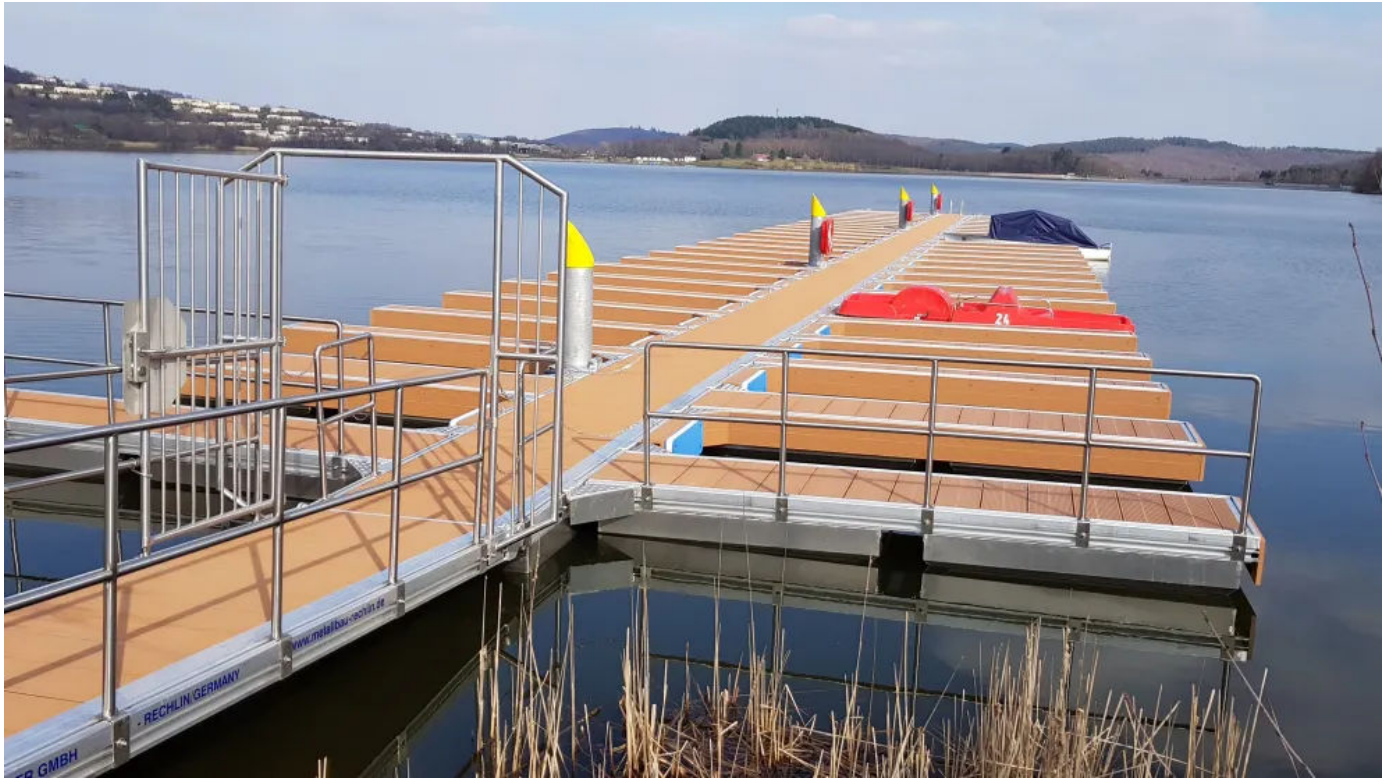
Erneuerung der Schwimmteganlage am Bostalsee: Die Belagsbohlen TRIMAX® nehmen kein Wasser auf und verrotten somit nicht
