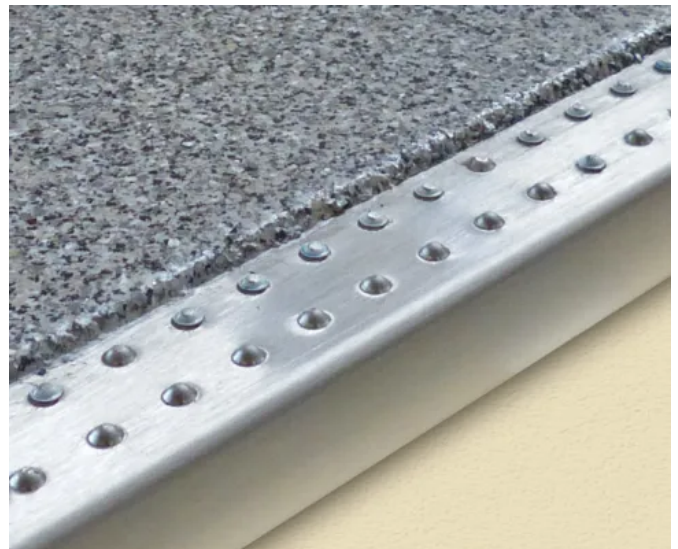
Randbeschichtung: Edelstahl Trittkantenschutz
