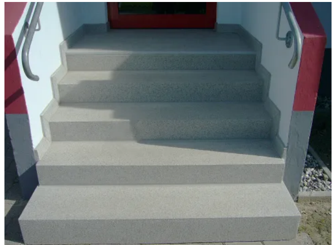
nach der Sanierung
