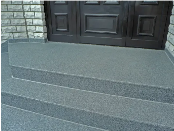
Treppenbelag mit Podestplatte im Eingangsbereich
