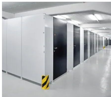
Selfstorage-Lagerboxen aus MultiGuard Stahlblechtrennwänden
