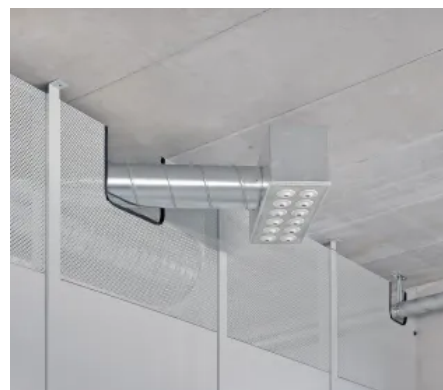
MultiGuard Stahlblechtrennwand mit Ausschnitt für Lüftung
