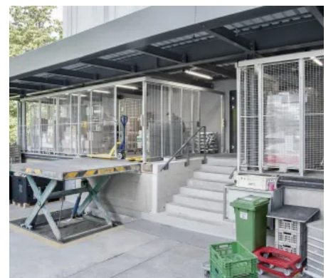
MultiSafe Gittertrennwände im Außenbereich, feuerverzinkt
