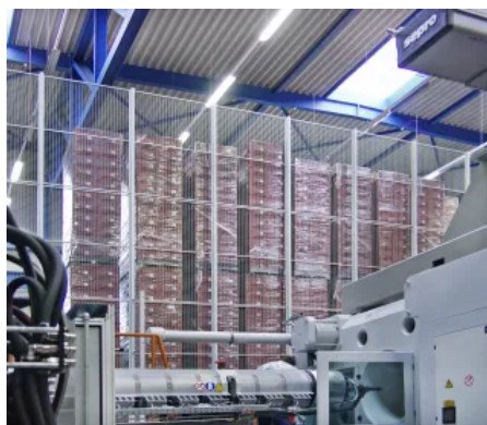
MultiSafe Gittertrennwände in einer Produktionshalle, Sonderhöhe
