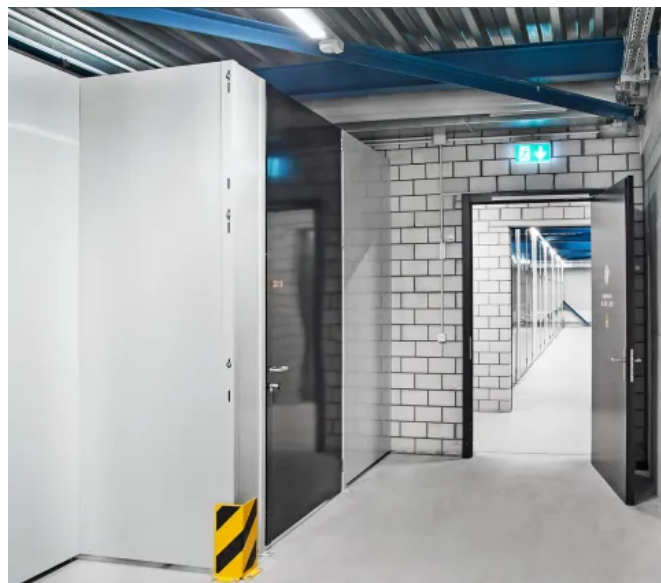
Unterteilung von Lagerräumen aus MultiGuard Stahlblechtrennwänden
