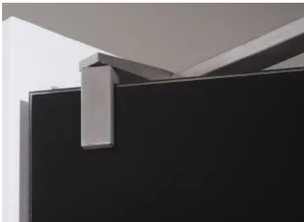
Oberer Halter der Scharnierkonstruktion. Die Tür wird im Kopfprofil geführt.
