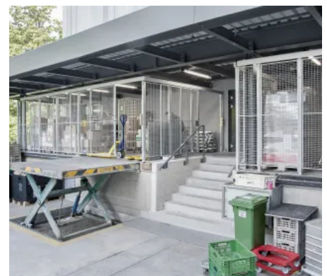
MultiSafe Gittertrennwände im Außenbereich, feuerverzinkt
