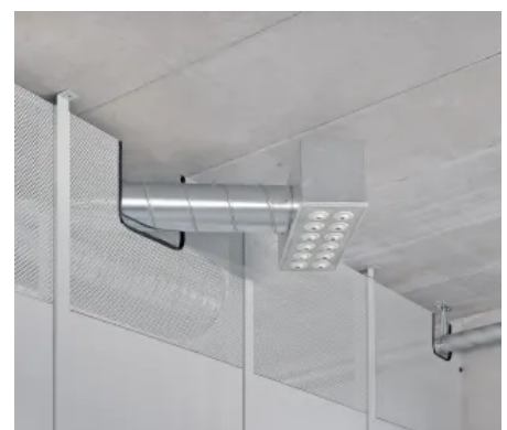
MultiGuard Stahlblechtrennwand mit Ausschnitt für Lüftung
