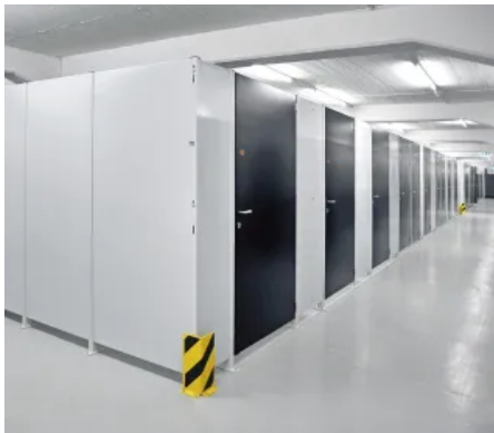
Selfstorage-Lagerboxen aus MultiGuard Stahlblechtrennwänden
