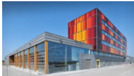
Feuerwehr Terneuzen (© Rodeca)
