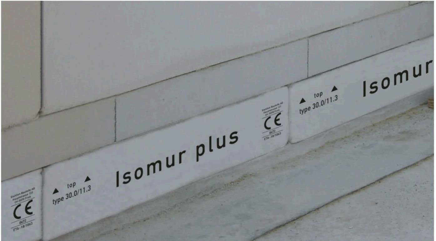
Mauerfußelemente Isomur® plus zur Dämmung des Gebäudesockels von gemauerten Wohnbauten
