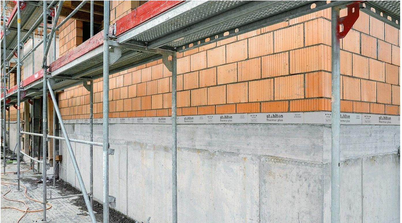
Mauerfüßelemente Isomur® plus zur Dämmung des Gebäudesockels von gemauerten Wohnbauten verhindern Wärmebrücken und somit raumseitige Feuchteschäden und Schimmelbefall im Sockelbereich. Sie sind bauaufsichtlich zugelassen nach Z-17.5-1215 bzw. ETA-18/1063.
