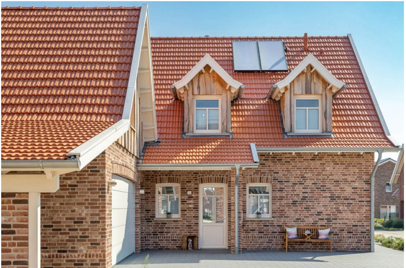
Ton-in-Ton-Gestaltung von Klinkerfassade und Doppelmuldenfalzziegel Z2.
