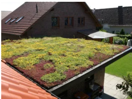
Dachdeckung mit TOPGREEN Gründachschale GDS 15 (© TOPGREEN)
