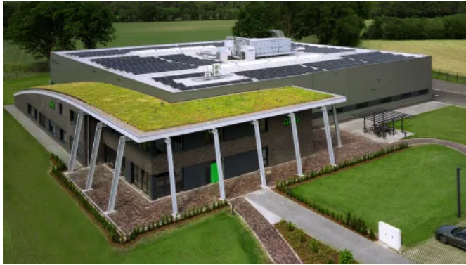
Dachdeckung mit TOPGREEN Gründachschale GDS 15 (© TOPGREEN)
