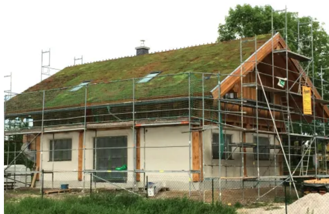
Dachbegrünung eines Blockhaus mit TOPGREEN Gründachpfanne GDP 30 (© TOPGREEN)
