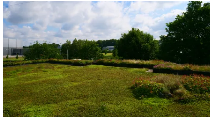
Dachdeckung mit TOPGREEN Gründachschale GDS 15 (© TOPGREEN)
