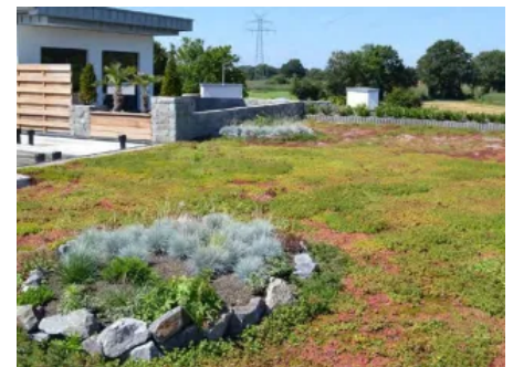
Dachdeckung mit TOPGREEN Gründachschale GDS 15 (© TOPGREEN)
