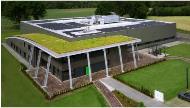
Dachdeckung mit TOPGREEN Gründachschale GDS 15 (© TOPGREEN)
