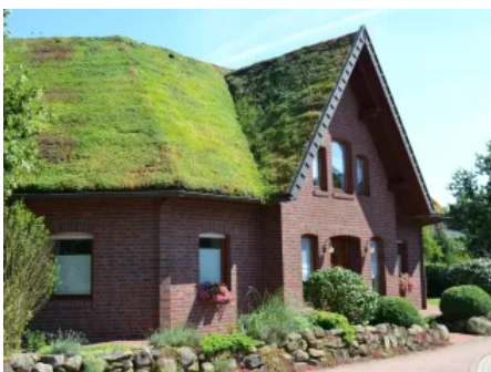
Einfamilienhaus im Wohngebiet Lohne mit TOPGREEN Gründachpfanne GDP 45 (© TOPGREEN)
