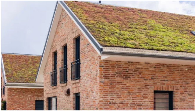
Dachbegrünung mit TOPGREEN Gründachpfanne GDP 45 (© Viebrockhaus)
