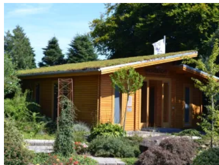
Dachdeckung mit TOPGREEN Gründachschale GDS 15 (© TOPGREEN)
