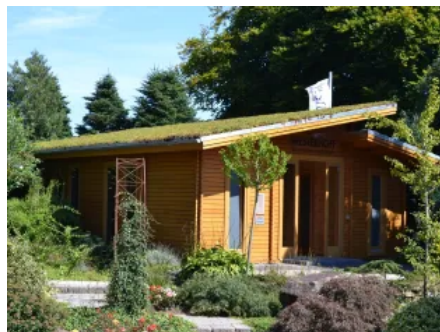
Dachdeckung mit TOPGREEN Gründachschale GDS 15 (© TOPGREEN)
