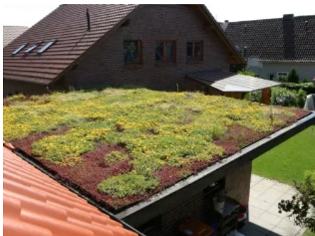
Dachdeckung mit TOPGREEN Gründachschale GDS 15 (© TOPGREEN)
