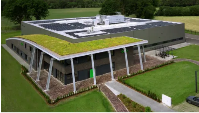
Dachdeckung mit TOPGREEN Gründachschale GDS 15 (© TOPGREEN)
