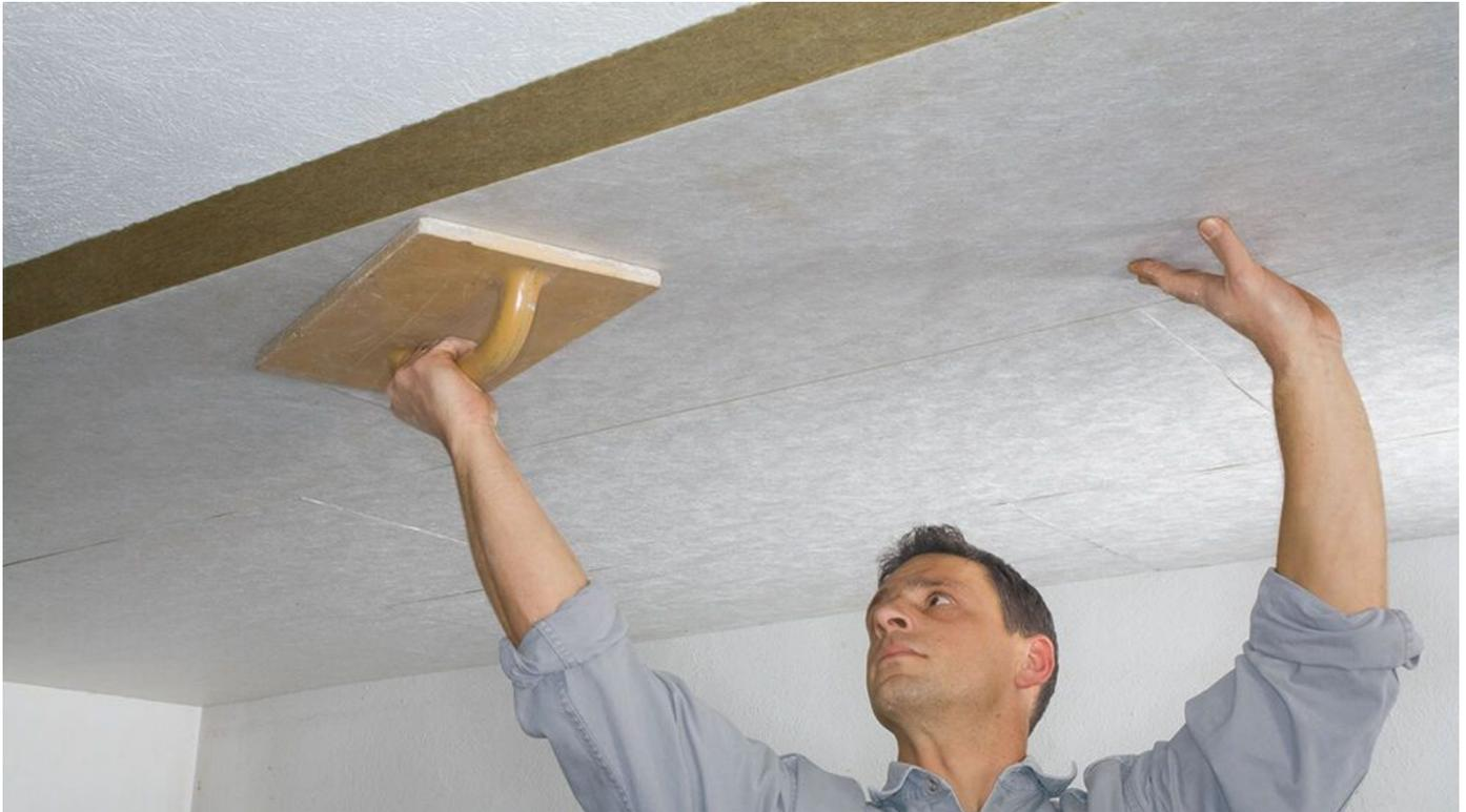
Nichtbrennbare Dämmplatten aus ULTIMATE oder Steinwolle für den Wärme-, Brand- und Schallschutz von Tiefgaragendecken.
