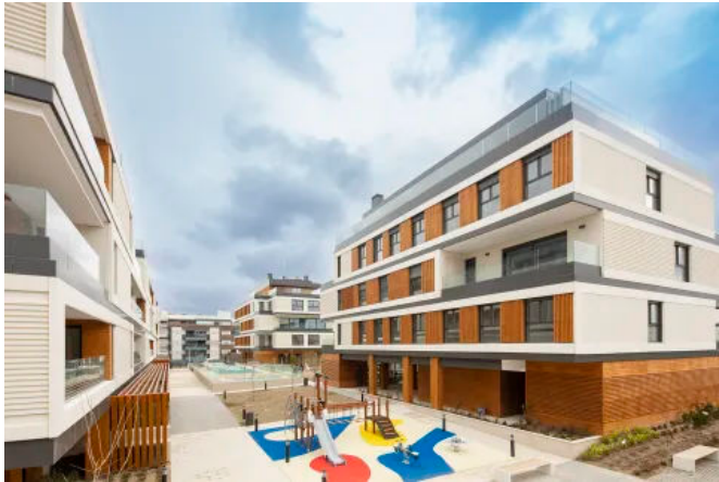
Wohnbauprojekt Alcobendas, Spanien
