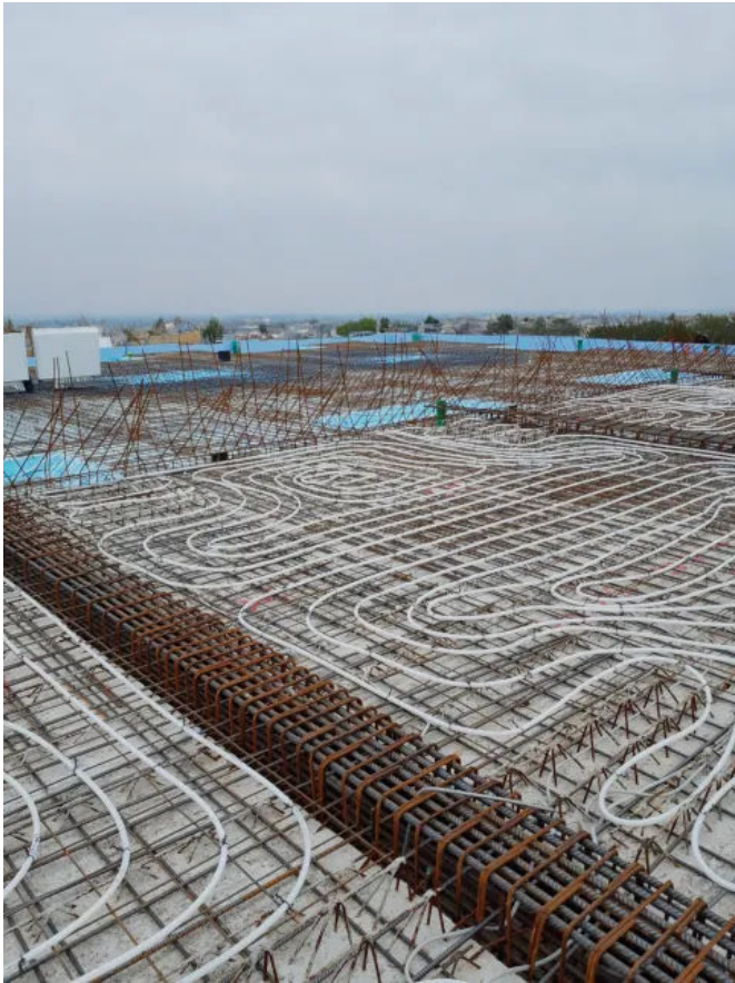
Auf vollständig erstellter FUTURA EnergieSpar-Bodenplatte wird eine Gewerbehalle montiert.
